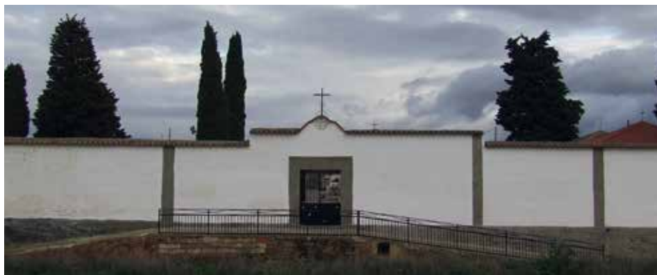
Fig.1 Fachada del cementerio actual.
