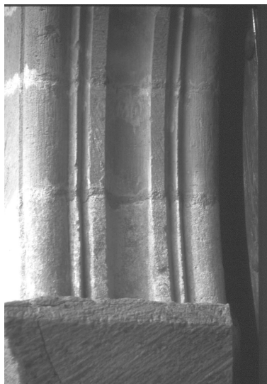
Fig. 2. Detalle del intradós del arco interior de la portada. (A.P.D. – a. 2014).
