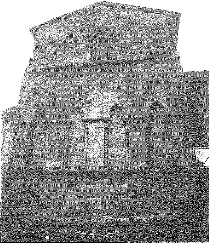
LÁMINA 1.- Vista actual del hastial Norte.
