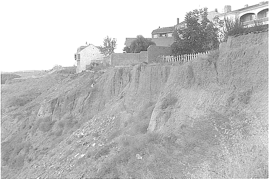
Foro 3.- Vertidos incontrolados en el escarpe de Los Cuestos de la Estación de Benavente.
