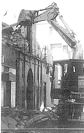
Foto 5.- Derribo de la «Casa del Tinte. (Foto Jesús).
