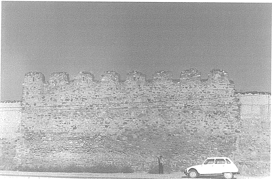
LÁM. 6.- Fotografía de los años setenta en la que aparece un lienzo de muralla con almenas, correspondiente al monasterio de San Bernardo, en la avenida General Primo de Rivera. (Foto Julián Cachón)
